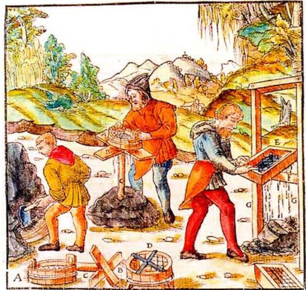
Bild 1: Historische Darstellung von Georg Agricola, flache und geneigte Siebmaschinen [1]
