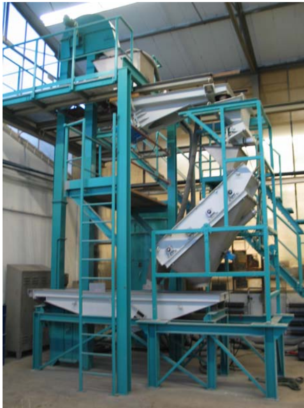
Bild 3: Direkt-Erregte-Siebmaschine RHEWUM-WAU im Kreislaufversuch
