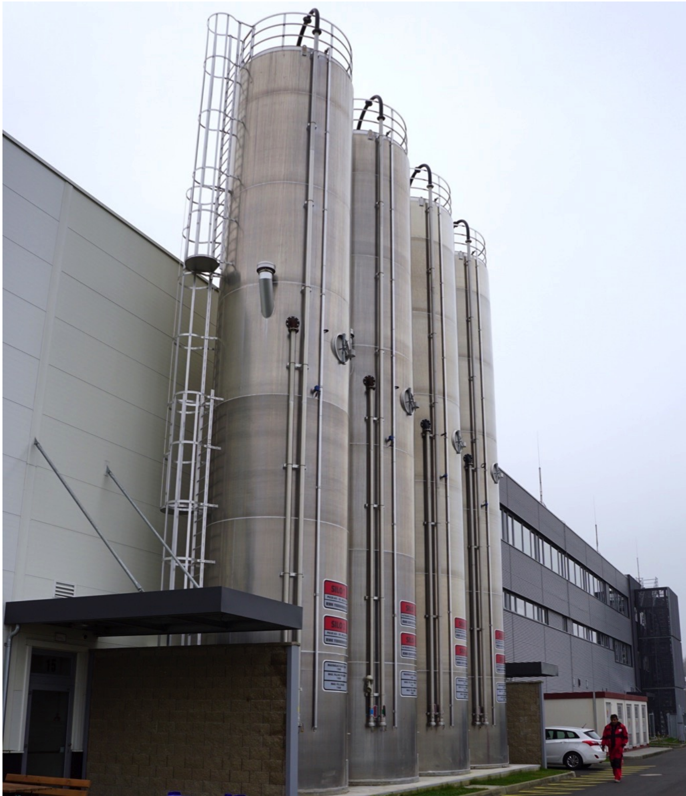
Abb. 4: Angeliefertes Material wird in vier Doppelkammersilos gelager. (Foto: Reinhard Bauer)
