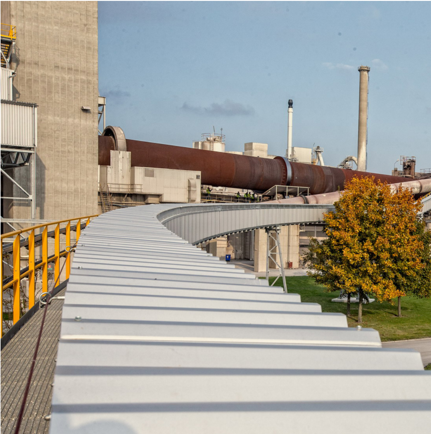
Bild 4: Der Pipe Conveyor fördert das Material direkt zum Drehrohrföfen. Bei der Konstruktion lassen sich Kurven einfach realisieren.
