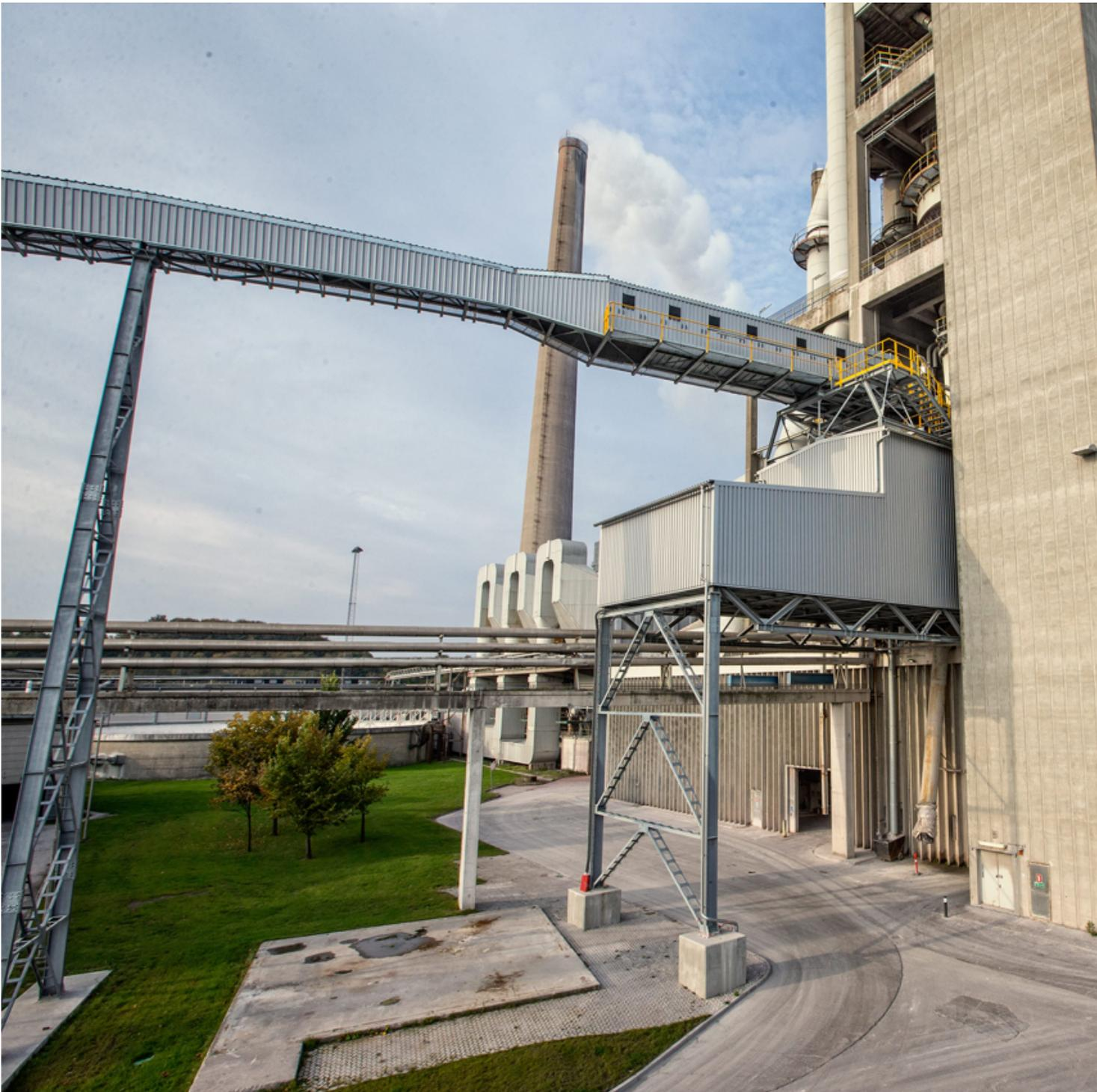
Bild 5: Das Penthouse befindet sich unterhalb der Abwurfstation des Pipe Conveyor zum Kalzinator. Hier sind der Zwischenbunker mit dem Aktivator und die beiden Doppel-Abzugsschneckenförderer untergebracht.
