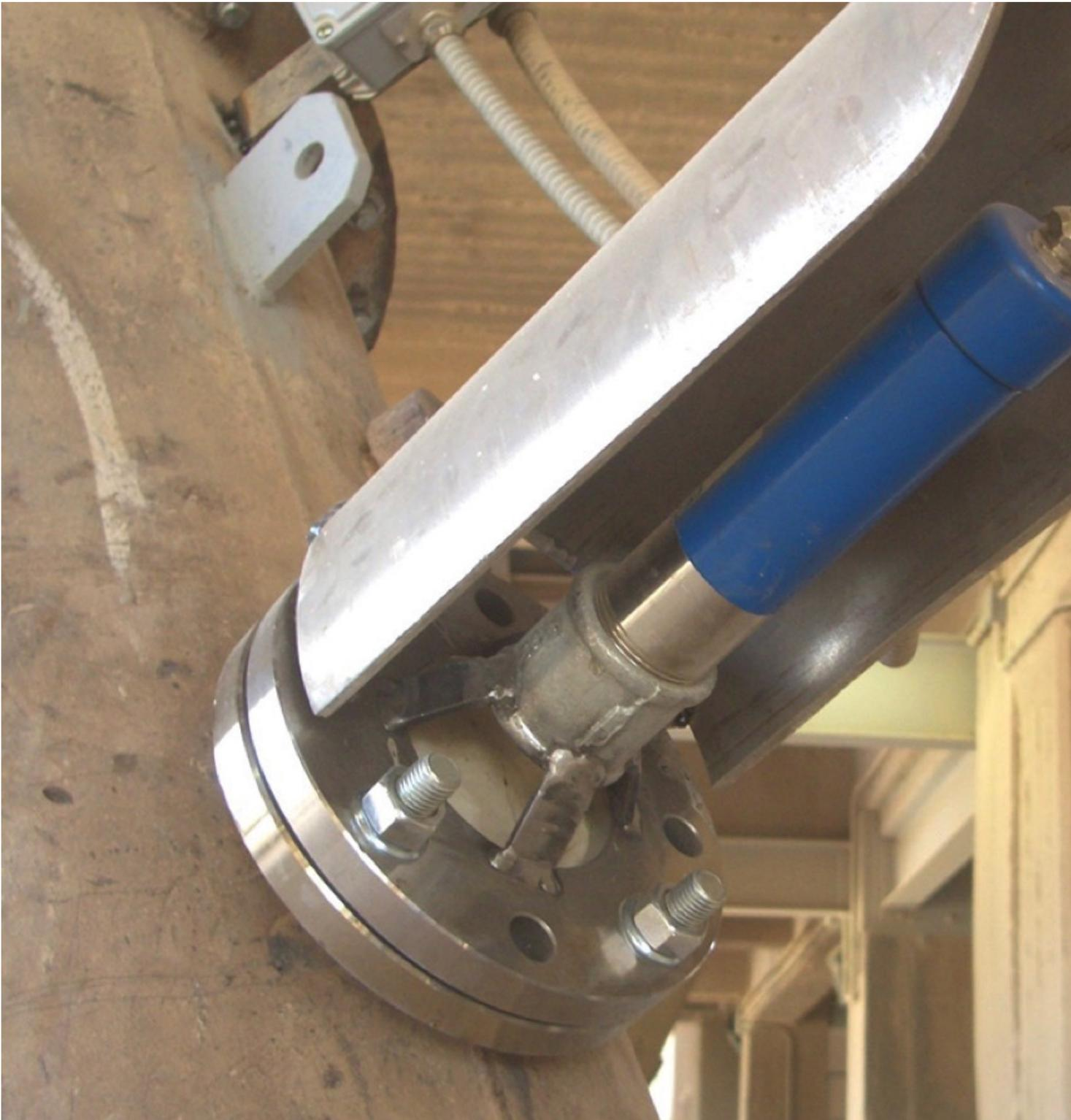
Durchflussüberwachung mit dem FlowJam Mikrowellendetektor an einem Zyklonenabscheider in der Zementindustrie. (Bild: SWR engineering)
